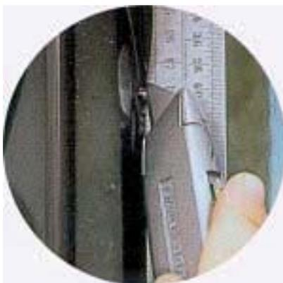
6- Araser le film autour de la vitre avec un cutter dont la lame est neuve, en faisant attention à ne pas endommager le support.
