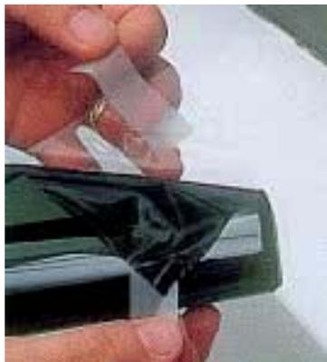
3- Séparer le film de réparation de son support utilisant des morceaux de ruban adhésif collés dans l'angle qui seront posés en haut du vitrage. Coller un morceau d'adhésif sur une face et un second morceau sur l'autre face. Tirer sur les morceaux d'adhésif pour séparer le film du support.
